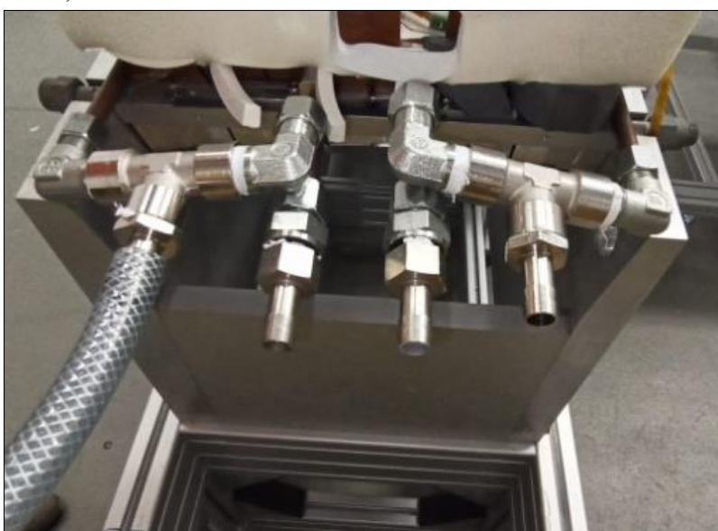
Рис. 14.10 - Трубки системы охлаждения и теплоизоляция, уложенная поверх них
